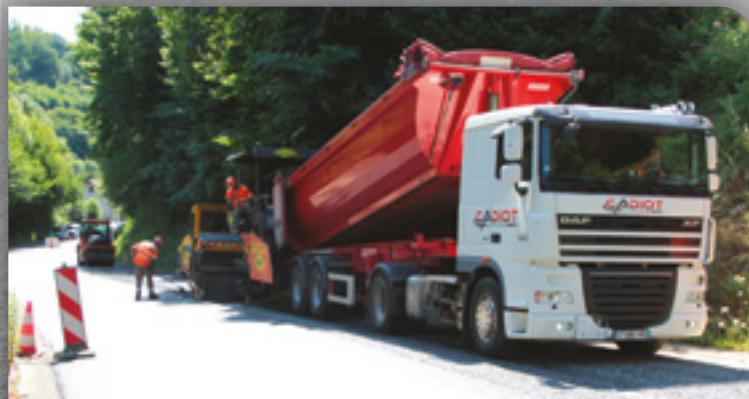
CHAMEYRAT - ROUTE DE POISSAC - RD 9 Travaux dans la côte de Poissac : 1,5 km de chaussée rénovée pour garantir la sécurité sur cet axe emprunté chaque jour par 5 000 véhicules.
