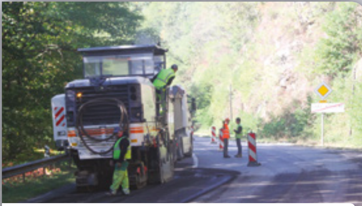
SAINT-HILAIRE-PEYROUX - GARE D'AUBAZINE - RD 1089 Rénovation de la chaussée (1,4 km) pour améliorer la qualité et la sécurité de cet axe soumis à de fortes contraintes : 10 000 véhicules/jour.
