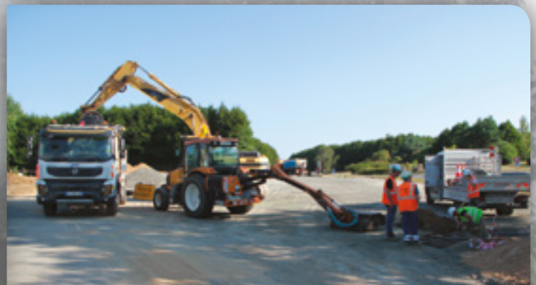
ESPARTIGNAC - AIRE DES BALLADOURS - RD 920 Augmentation de la capacité d'accueil de 35 à 70 places, de cette aire de covoiturage très fréquentée, à proximité d'Uzerche et de l'échangeur de l'autoroute A20.
